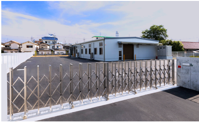
北東面入口外観
